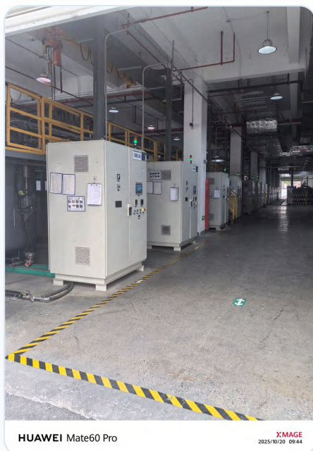
图：远航 工业炉 -立式超高温石墨化现场安装
